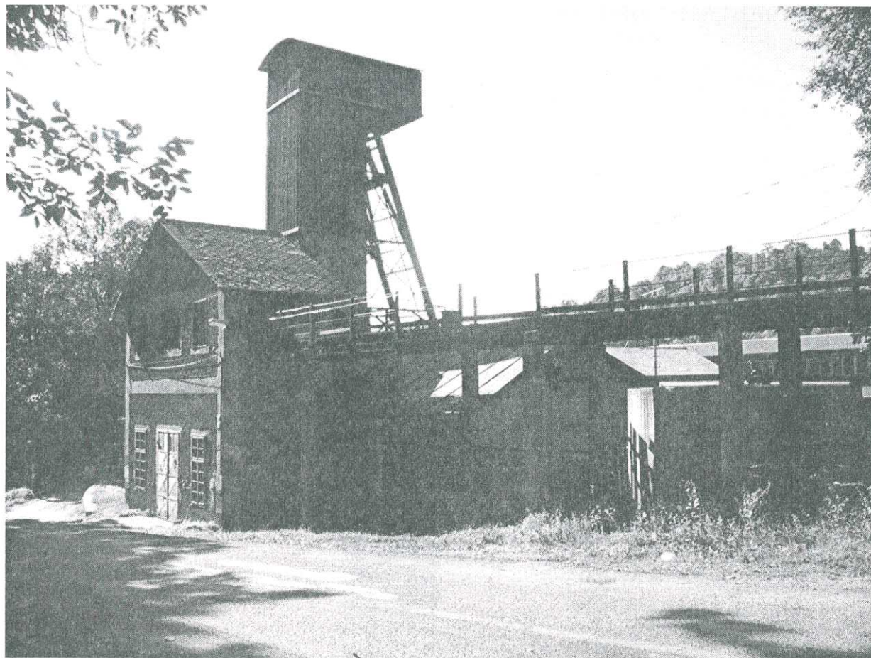
Šachta IV., kde je prístup do podzemnej elektrárne
