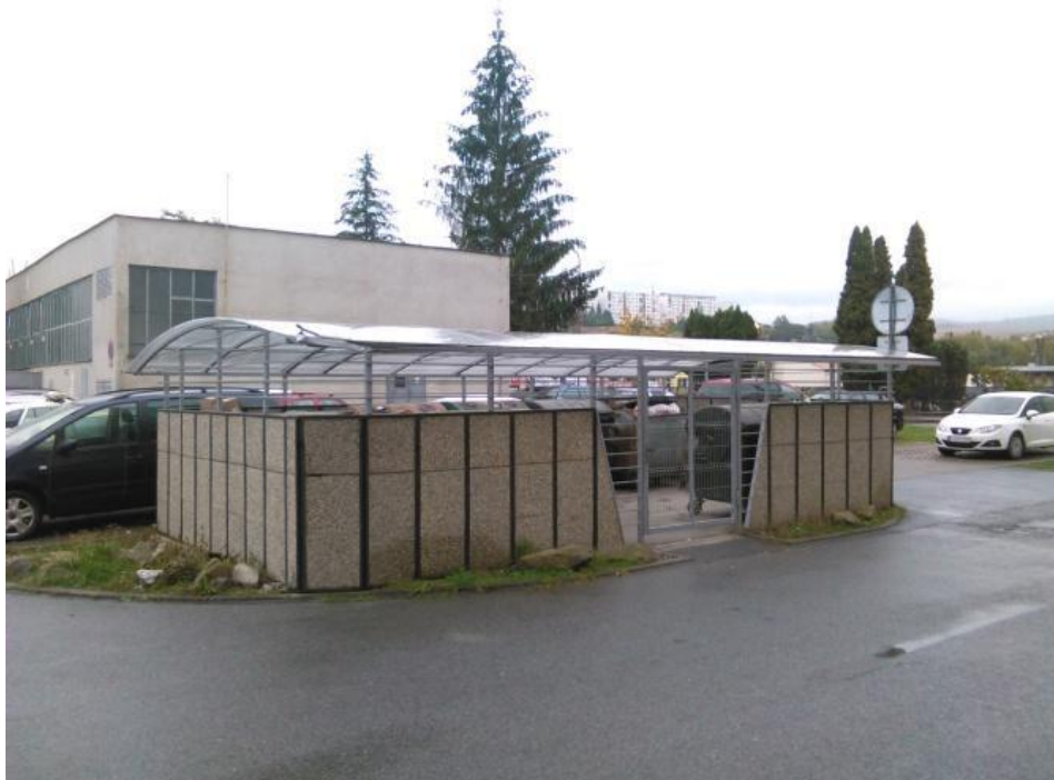
Obr. 6 Rekonštrukcia stojiska z jestvujúceho oplôtku (ul. Slovenská)
