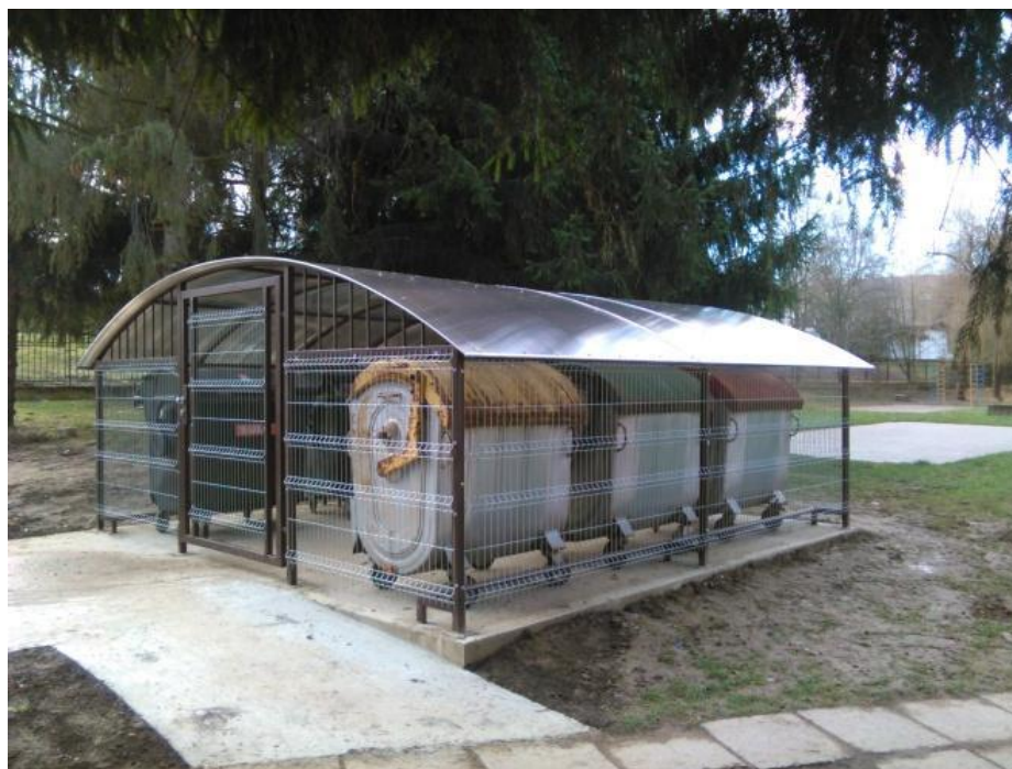
obr. 5 Novovybudované stojisko (ul. Komenského – vstup od ul. Sv. Jakuba)
