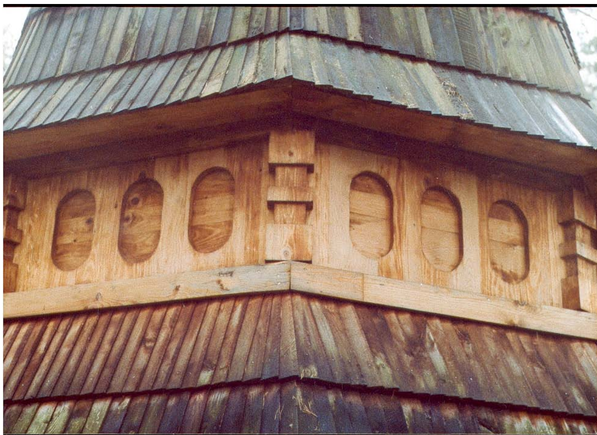
Fryz w uskoku wieży cmentarza nr 55 w Gładyszowie (for. A. Piecuch)
