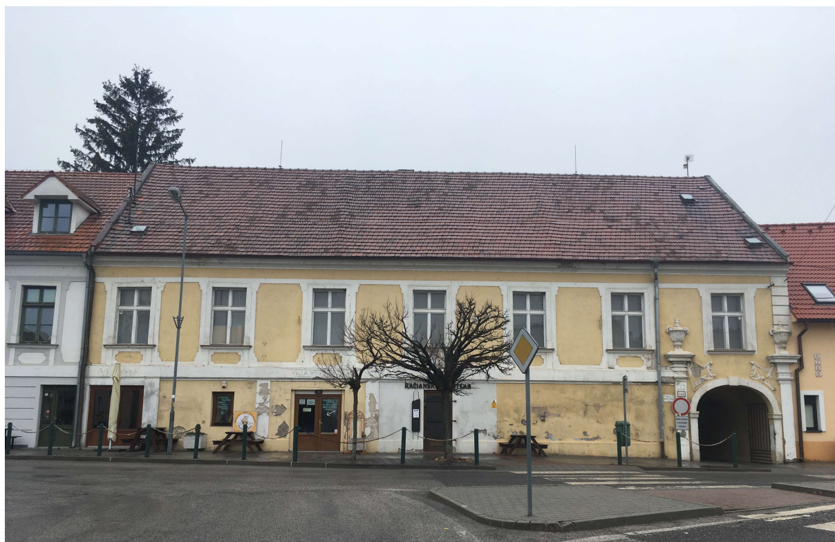
Obr.2: Čelná fasáda objektu Račianskej kúrie, foto: autor MD, 2019
