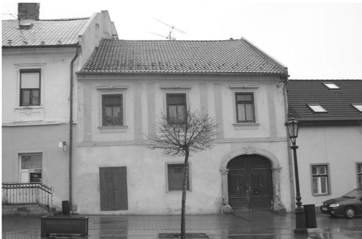
Obr. 1 Uličná fasáda domu Podmanických, stav pred obnovou v roku 2007. (foto: SABADOŠOVÁ, E. )
