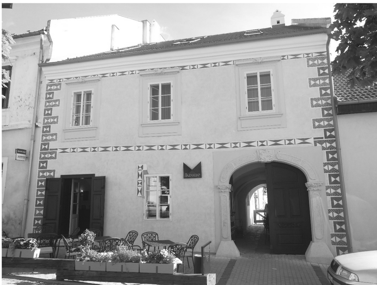
Obr. 8 Uličná fasáda po obnove v r. 2019. (foto: VAŠČÁK, M.)
