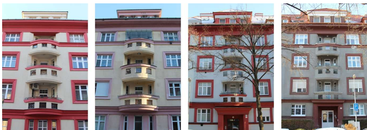
Obr.1: Legiodomy, pamätihodnosti Bratislava-Nové mesto, bytové domy na Ursínyho ulici. Architekti Dušan Jurkovič a Josef Pacl. Rôznorodá farebnosť fasád v uličnom priehľade pôsobí rušivo. Zatepľovaním a novými konštrukciami na fasádach sa potláča architektonický výraz rondokubistickej architektúry.
