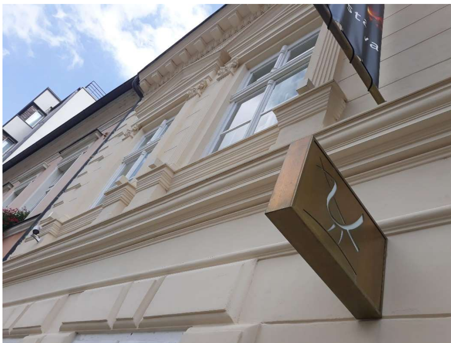
Obr.5: Detail fasáda po sanácii - rímsa
