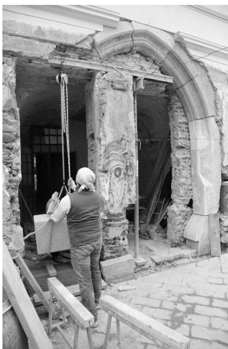
Obr. 7 Doplnenie chýbajúcich častí gotického portálu (foto autor)
