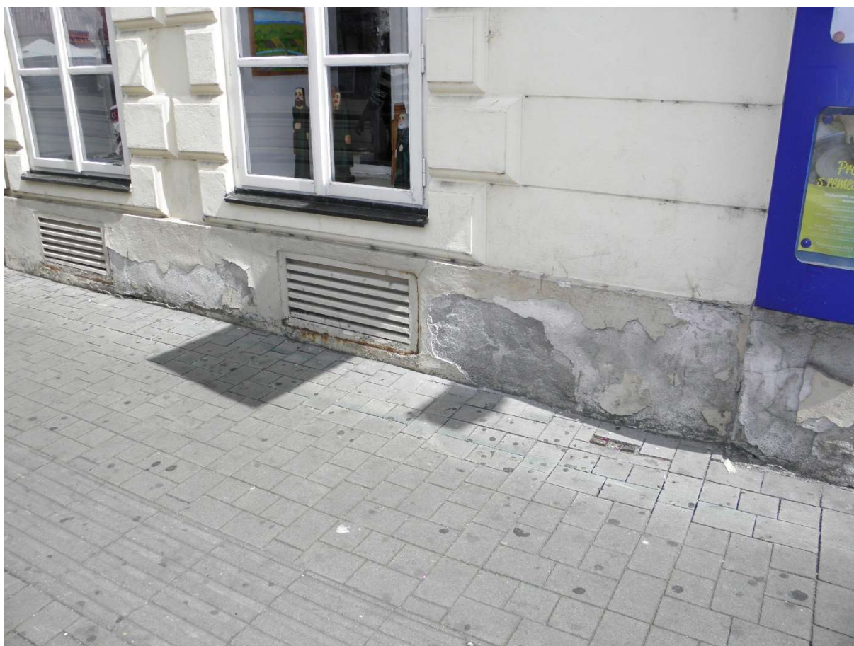
Obr.2: Pôvodný stav sokla fasády
