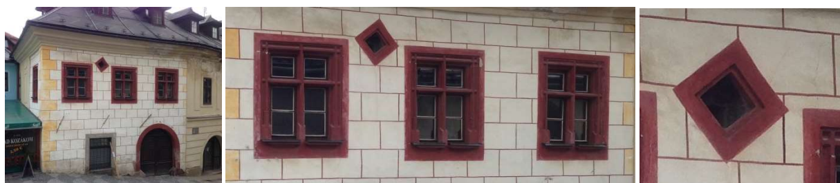
Obr. 3: Banská Štiavnica, stredoveká fasáda a stredoveké okenné otvory.
