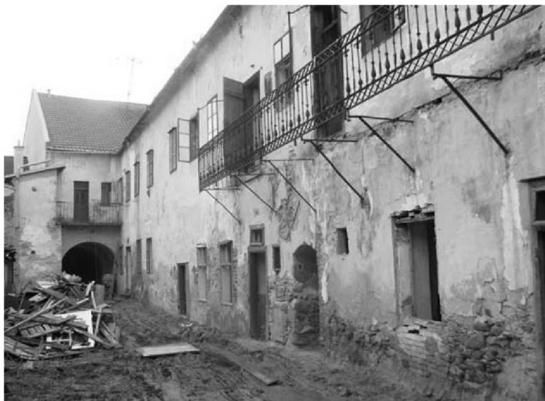
Obr. 6 Stav dvorovej fasády pred obnovou v r. 2007 (foto: SABADOŠOVÁ, E.)
