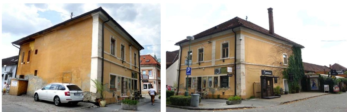
Obr.3: Pohľad na východné (vľavo) a severné nárožie (vpravo), stav 07/2018, foto Grúňová.
