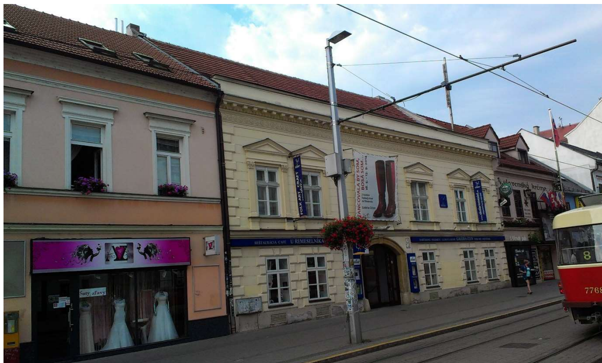
Obr.1: Pôvodný stav fasády
