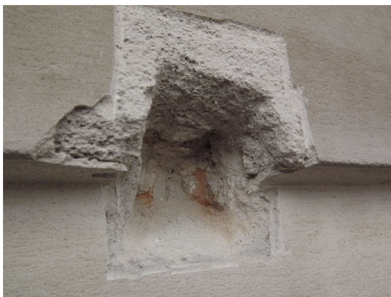
Obr. 3: Sonda v mieste kontaktu korunnej rímsy a vlysu, kde je asi 15 cm hrubá vrstva novodobých omietok na barokovom tehlovom murive. Na preškrabanom tehlovom murive sa nachádza cementový podnástreč a na ňom asi 7 cm vrstva nastavovanej omietky z obdobia obnovy v šesťdesiatych rokoch 20. storočia. Na nej je približne rovnako hrubá vrstva novšej cementovej omietky z rokov 1993 – 1996. Na týchto vrstvách sa nachádza asi 1cm hrubá vrstva hladkej vrchnej omietky a súčasný náter (archív spol. PAMARCH, s.r.o.).
