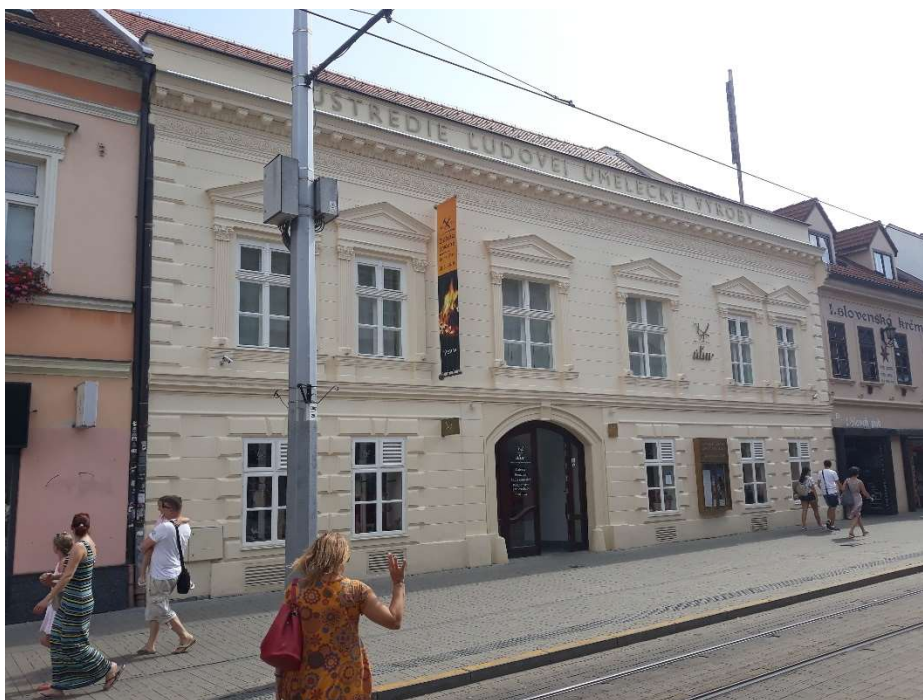
Obr.3: Fasáda po sanácii
