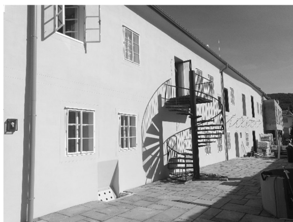
Obr. 12 Dvorová fasáda po obnove v r. 2019 (foto: VAŠČÁK, M.)
