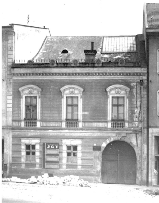
Obr. 2: Stav uličnej fasády, fotografia, 1974. Zdroj: archív E. Kráľovej
