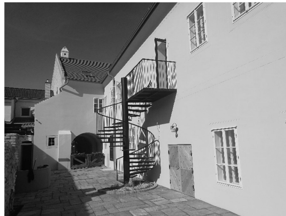
Obr. 13 Dvorová fasáda po obnove v r. 2019 (foto: VAŠČÁK, M.)
