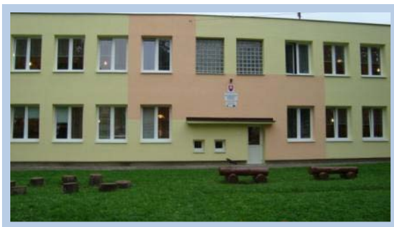
Rekonštrukcia MŠ ul. Nábřežna
