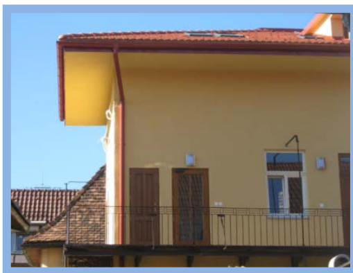
Radničné nám. č.30 – rekonštrukcia bytov
