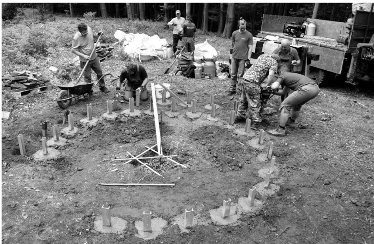
Obr. 4. Vrtanie dier a betonáž kovových konzol stĺpov
