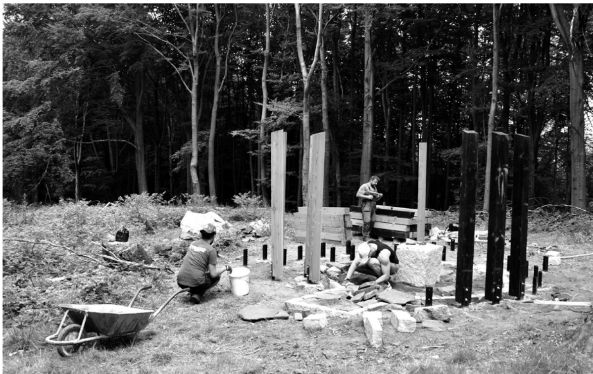
Obr. 5. Inštalácia drevených stĺpov pamätníka
